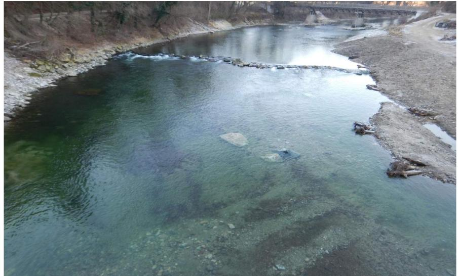
Strukturverbesserungen an der Laßnitz: Auf ca. 600 Meter Länge im Bereich flussauf und flussab der Pöllmühle wurde die harte Uferverbauung entfernt und Strukturvielfalt aus Stein und Totholz eingebracht. Eine wesentliche Aufwertung auch hier.
